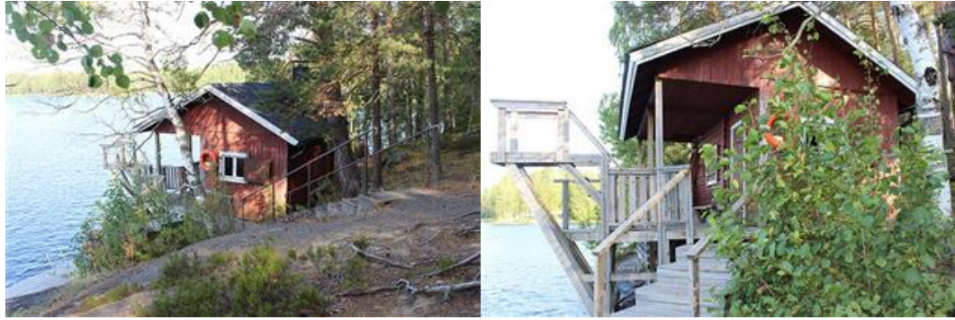
KUVAT: Rantasaunan julkisivuja
