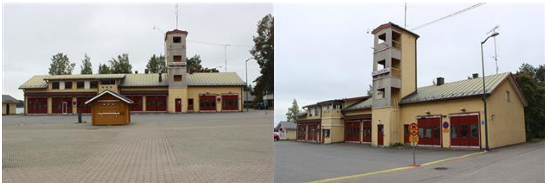
KUVAT: Paloaseman julkisivuja
